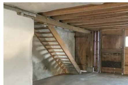
Eingang/Aufgang OG vorher
